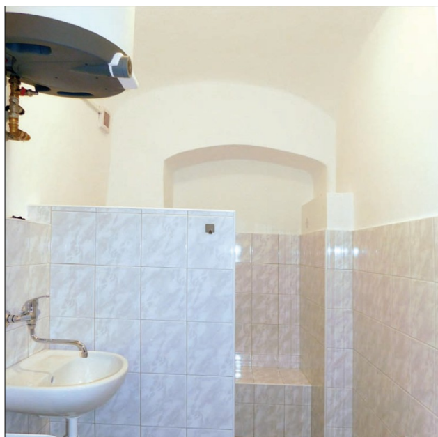
foto č. 10: Elektrický bojler 150 l
