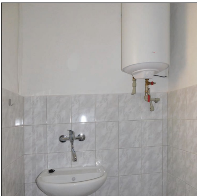
foto č. 9: Elektrický bojler 100 l
